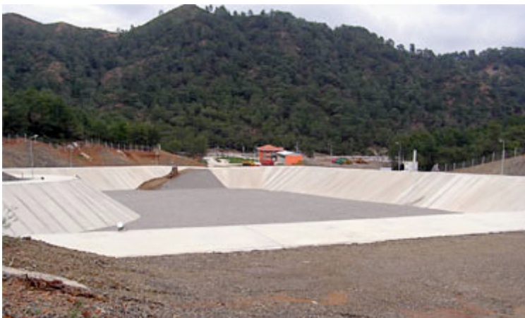
Dichte Planen schützen das Erdreich einer regulären Deponie
